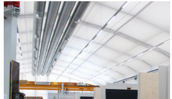
Bild links: Leichtbauhalle mit Rolltoren Bild unten: Blick auf die schlanken Stahlprofile (Doppel-T-Träger), abgeschirmt durch Innenmembran
