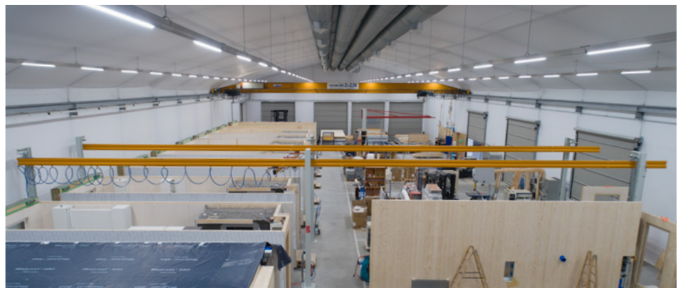
Blick in die Leichtbauhalle mit Kranbahnen und Portalkran sowie den Rolltoren
