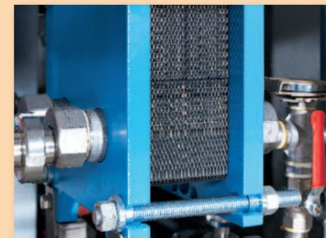
Aufbau des Platten-Wärmetauschers
